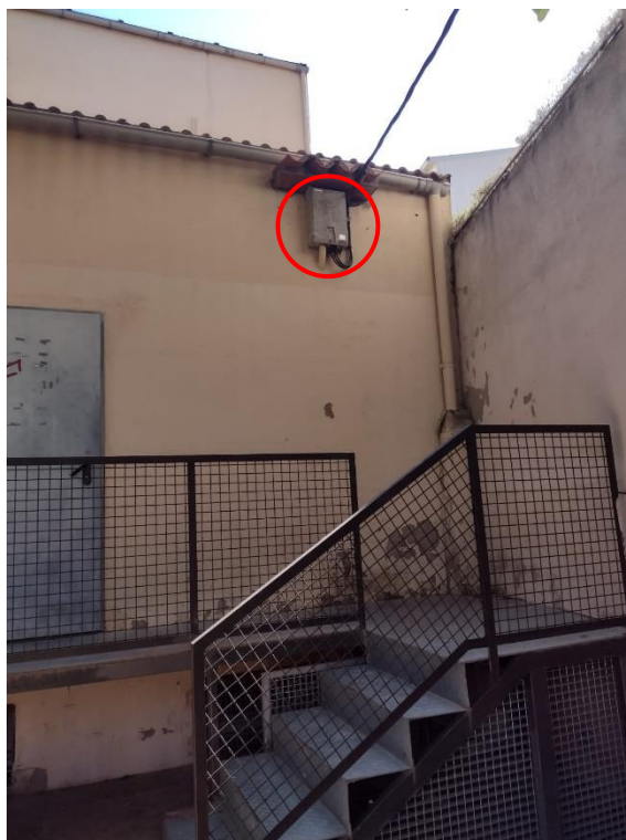
Figura 15. Caixa de Seccionament existent
